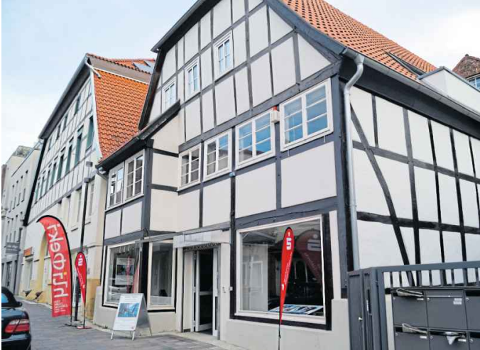
Die Galerie ist im Erdgeschoss dieses Fachwerk-Gebäudes an der Niedernstraße untergebracht.
